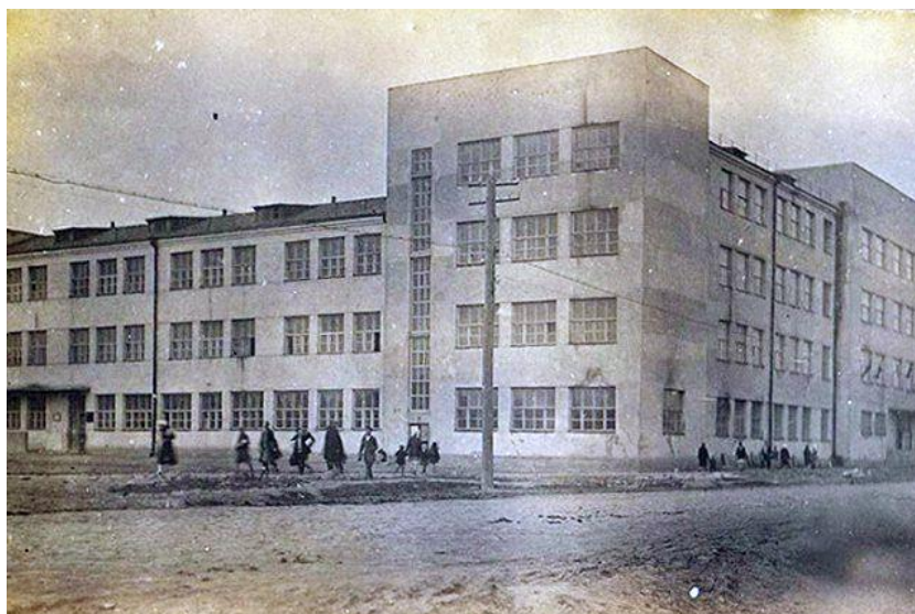
Рис. 4. Здание ПРОМЭКТа (Техникума Совторговли) на ул. Декабристов, 20
