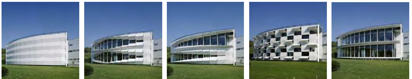
Рисунок 17. Кинетический фасад здания Kiefer Technic (архитектурная студия Ernst Giselbrecht + Partner) (Австрия): а–д) варианты трансформации фасада [40]
