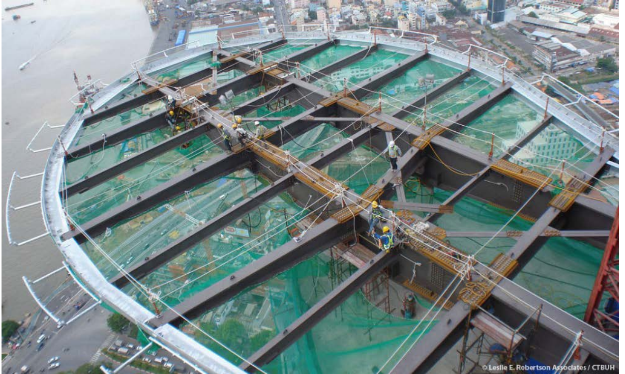
Рисунок 49 – Монтаж конструкции вертолётной площадки. Bitexco Tower в г. Хошимине, 2007-2010 гг.
