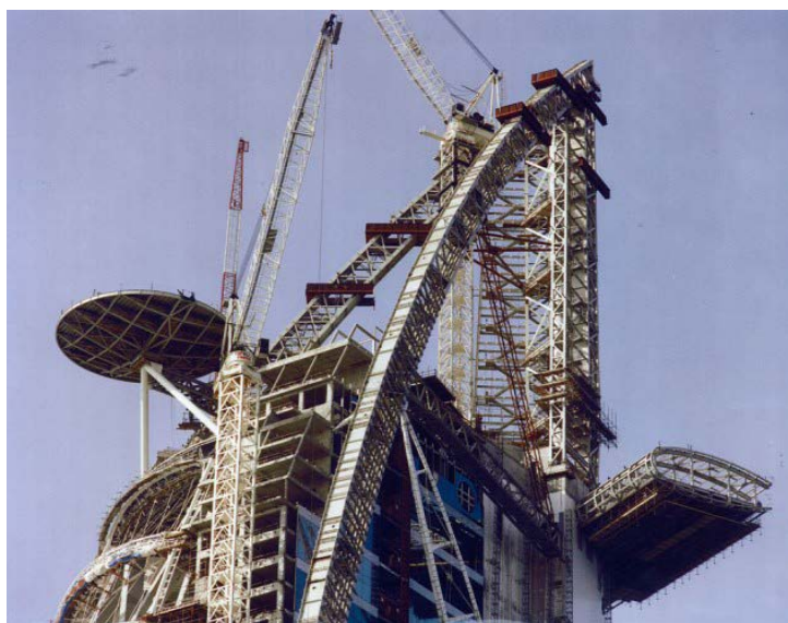
Рисунок 48 – Строительство здания отеля «Бурдж аль Араб» г. Дубай. ОАЭ, 1994-1999 гг.
