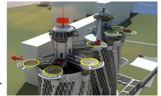
Вид на посадочные площадки днем.
