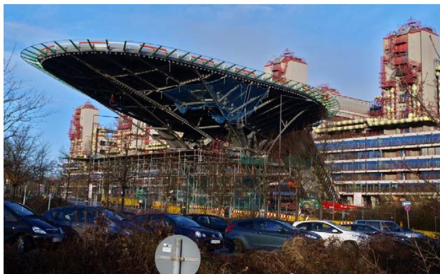
Рисунок 47 – Строительство вертолетной площадки клиники нейрохирургии в городе Ахен, Германия, 2017 г.
