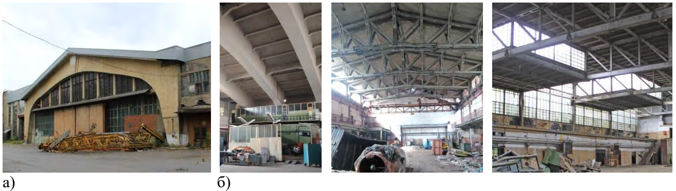
Рис. 15. Бывший авиазавод «Знамя Труда» в Москве (фото автора, 2018 г.): а) ангар № 7; б) примеры железобетонных, деревянных и металлических конструкций покрытий исторических корпусов завода (подробнее – см. Приложения 31, 32).
