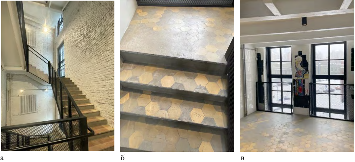
Рис. 17. Лестнично-лифтовой блок комплекса: а – сохранена фактура кирпичной стены; б – сохранена плитка, в местах утраты – бетон; в – сохранено позднее панно, выложенное глазурованной плиткой – изображена девушка с хлебом.
