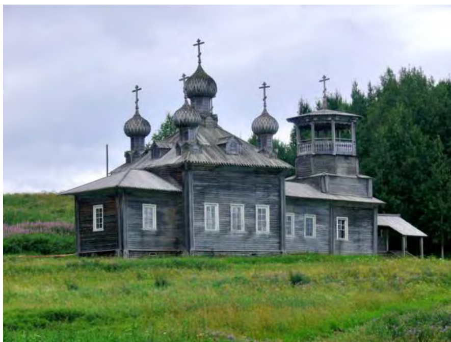
47.Заозерье (Кельчемгора). Церковь Николая Чудотворца
