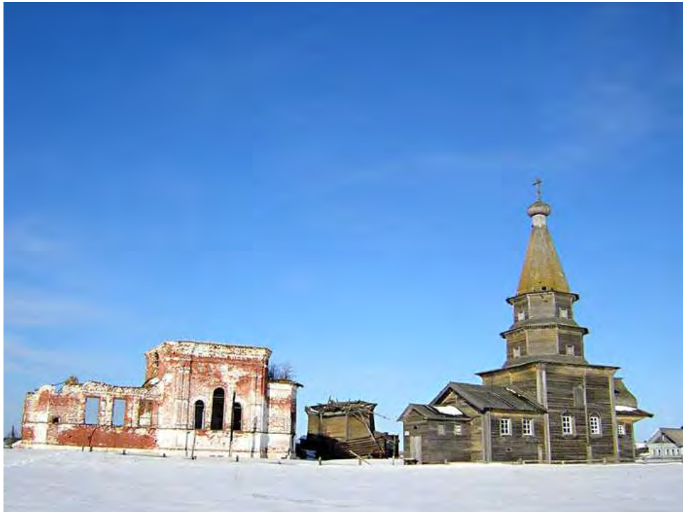
52. Погост (Ратонаволоок). Храмовый комплекс. Церкви Николая Чудотворца (кирпичная и деревянная) и Петра и Павла
